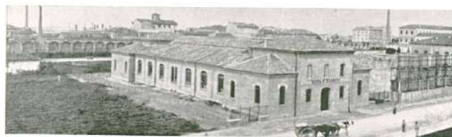
Stabilimento in via Milazzo.
