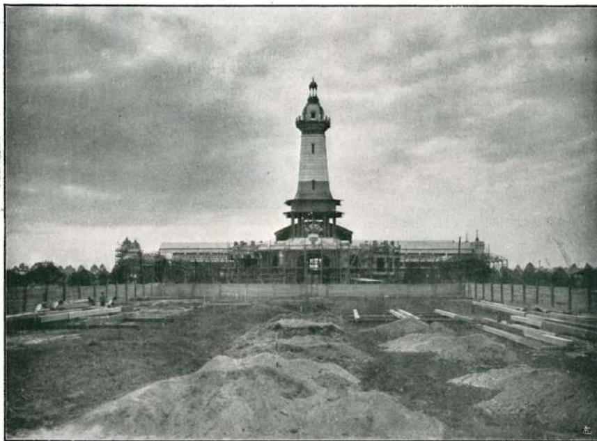
** Lo stato attuale dei lavori della « Galleria di Marina e del Faro ».
