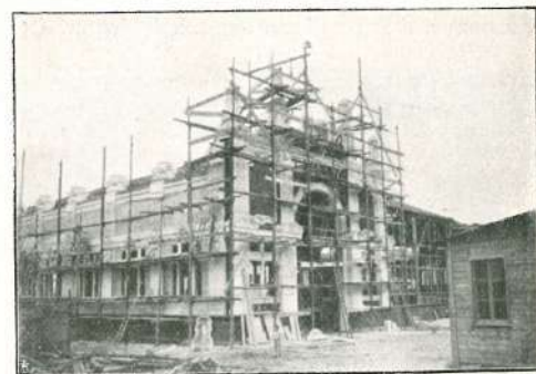
** Il « Palazzo della Carrozzeria ». Stato attuale dei lavori.
