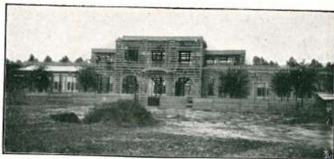
** Lo stato attuale dei lavori della « Caserma dei Pompieri ».
