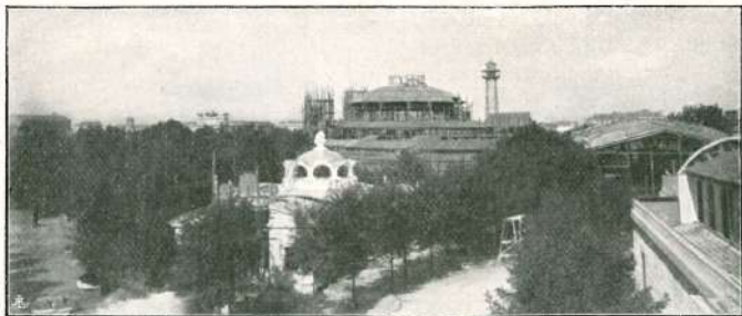
** Veduta della « Galleria di Belle Arti » e del « Salone dei festeggiamenti » in costruzione.
