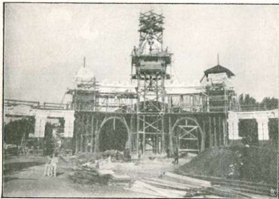
** L'ingresso ai due tunnels della « Mostra del Sempione ».
