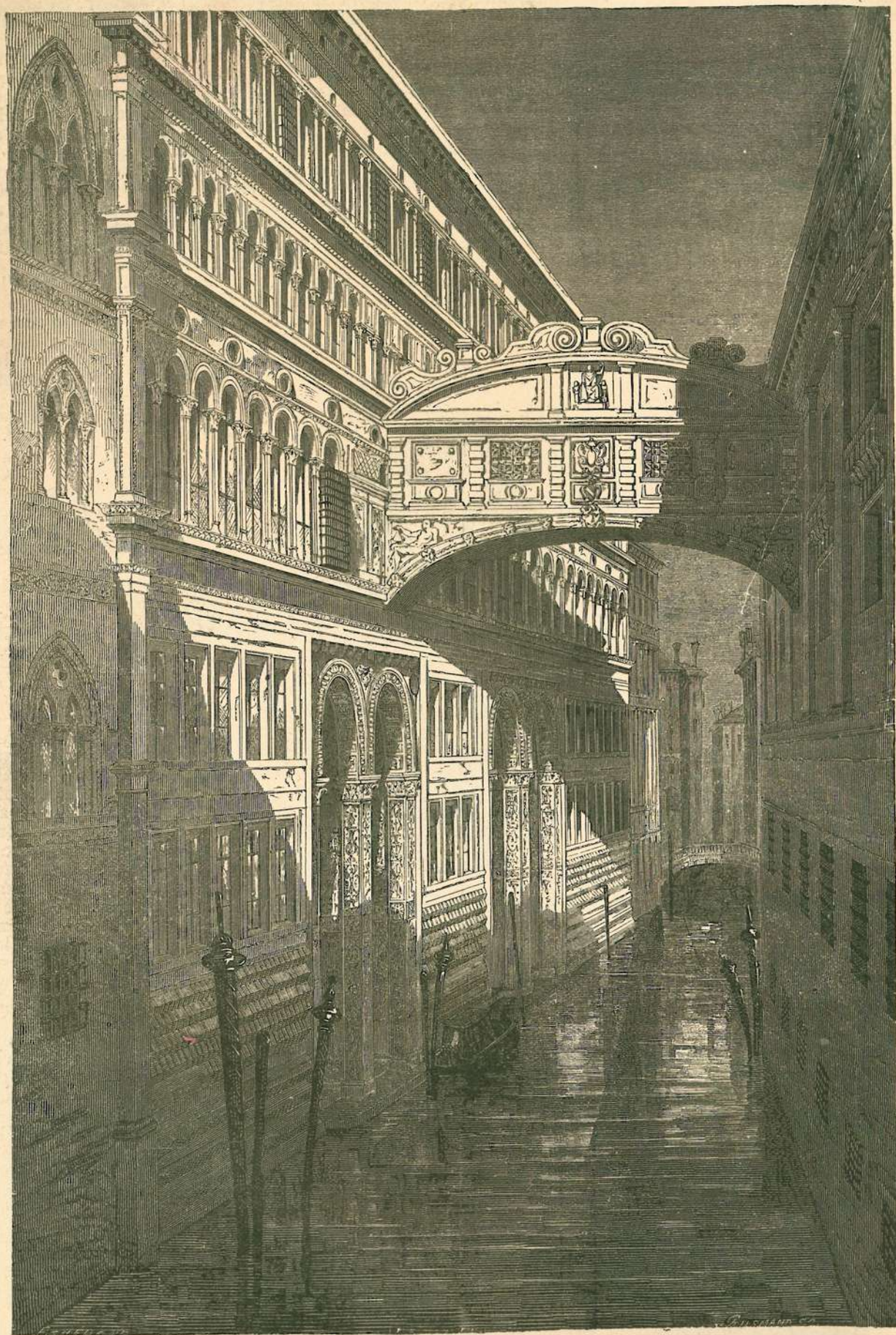
VENEZIA: IL LATO DEL PALAZZO DUCALE CHE ORA PRESENTA CEDIMENTI MINACCIOSI.
