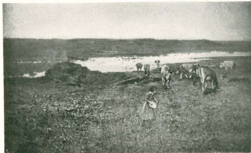
Fot. Italo Pacchioni, Milano.
