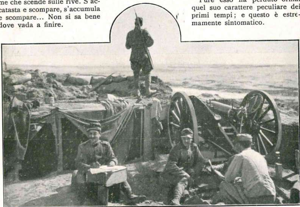
CORRISPONDENZA, LETTURA E VIGILANZA DI FRONTE AL DESERTO.
