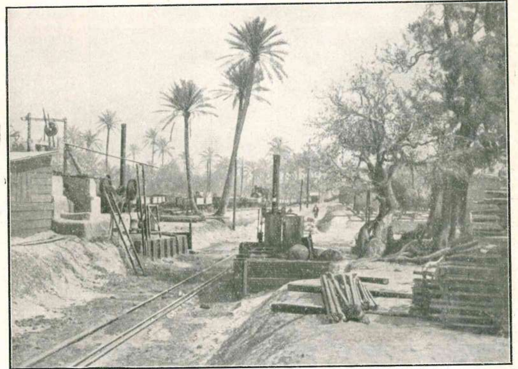
I LAVORI SULLA FERROVIA DI AIN-ZARA.
