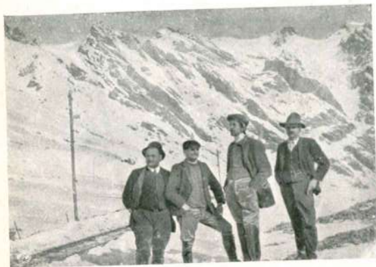
Fig. 4. — La linea ferroviaria in costruzione in uno dei punti più alti delle Ande ed i quattro impiegati italiani.
