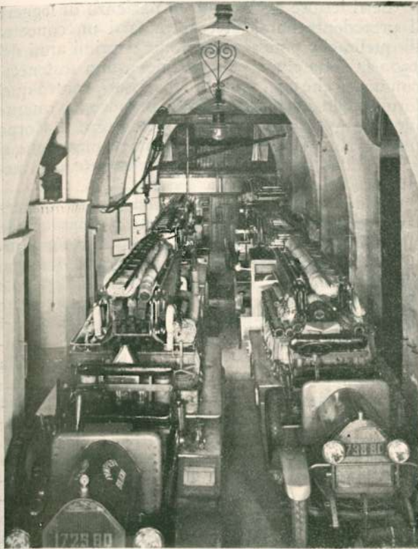
Magazzino autopompe e scale
