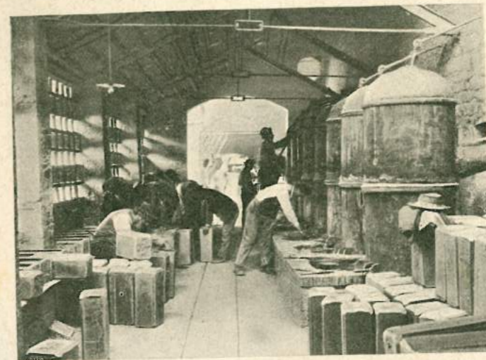
(Fig. 13). INTERNO DI UNA RAFFINERIA. FORMAZIONE DEI PANI DI ZOLFO.
