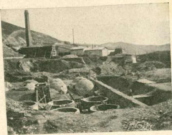
(Fig. 12). FORNI GILL IN COSTRUZIONE.
