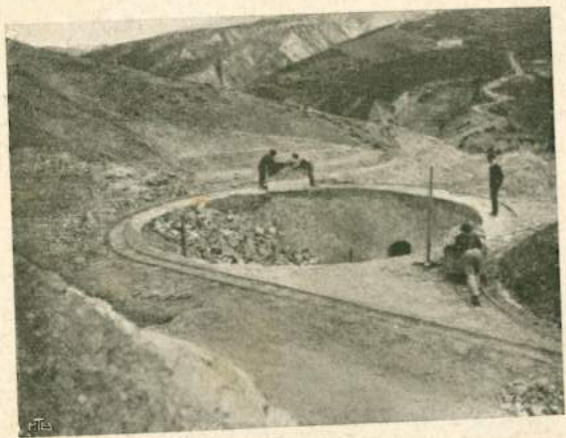
(Fig. 11). RIEMPIMENTO DI UN CALCARONE. — A DESTRA SCORGESI IL LEMBO DI UN ALTRO GIÀ FORMATO.
