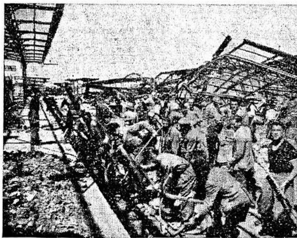
Fervono i lavori di riattivazione alla nostra stazione (Foto: «Corriere dell'Emilia»)
