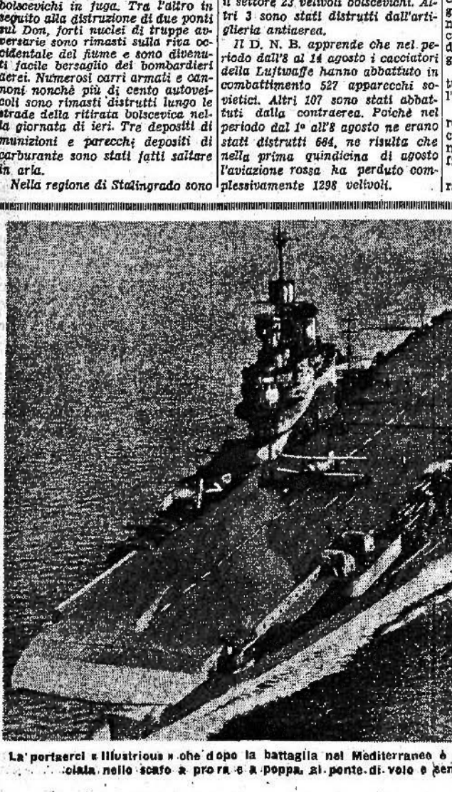
La portaerei illustrata che dopo la battaglia nel Mediterraneo è riparata a Gibilterra scagliata nello scafo a prora e a poppa, al ponte di volo e senza una torce binata.
