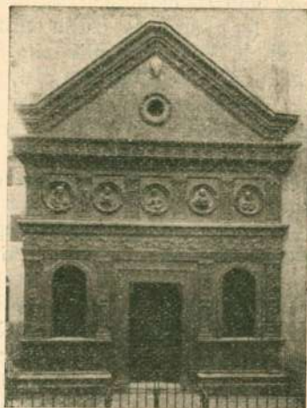
Facciata dello Spirito Santo
